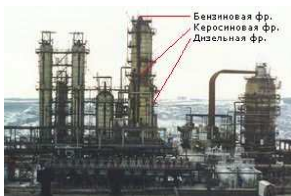
Рисунок 3 – Установка ЭЛОУ-АВТ-6 Саратовского НПЗ. В центре – атмосферная колонна (показаны точки отбора фракций), справа – вакуумная
